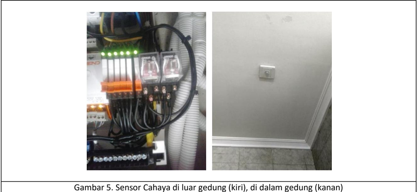
Gambar 5. sensor lampu yang digunakan untuk menyalakan dan mematikan lampu secara otomatis. Gambar di sebelah kiri menunjukkan sensor cahaya yang akan menyalakan lampu luar ruangan secara otomatis hanya saat hari gelap. Sedangkan gambar di sebelah kanan menunjukkan sensor cahaya di dalam ruangan yang akan menyalakan lampu ruangan secara otomatis hanya ketika sensor mendeteksi keberadaan orang di dalam ruangan.
