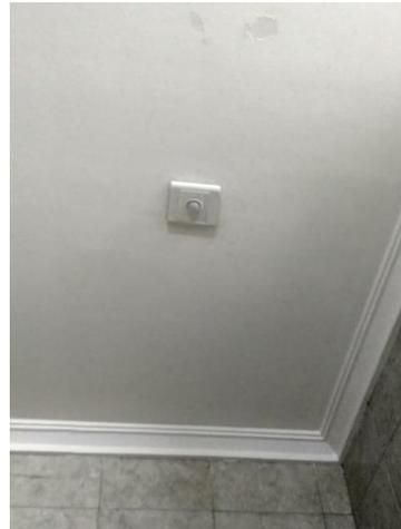
Gambar 8. Lampu toilet dipasang dengan sensor jarak
