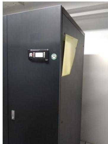
Gambar 4. Panel Kontrol Energi di dalam setiap gedung (pengontrol AC terintegrasi dengan PLC)
