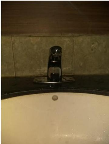
Gambar 7. Wastafel terintegrasi dengan faucet sensor jarak
